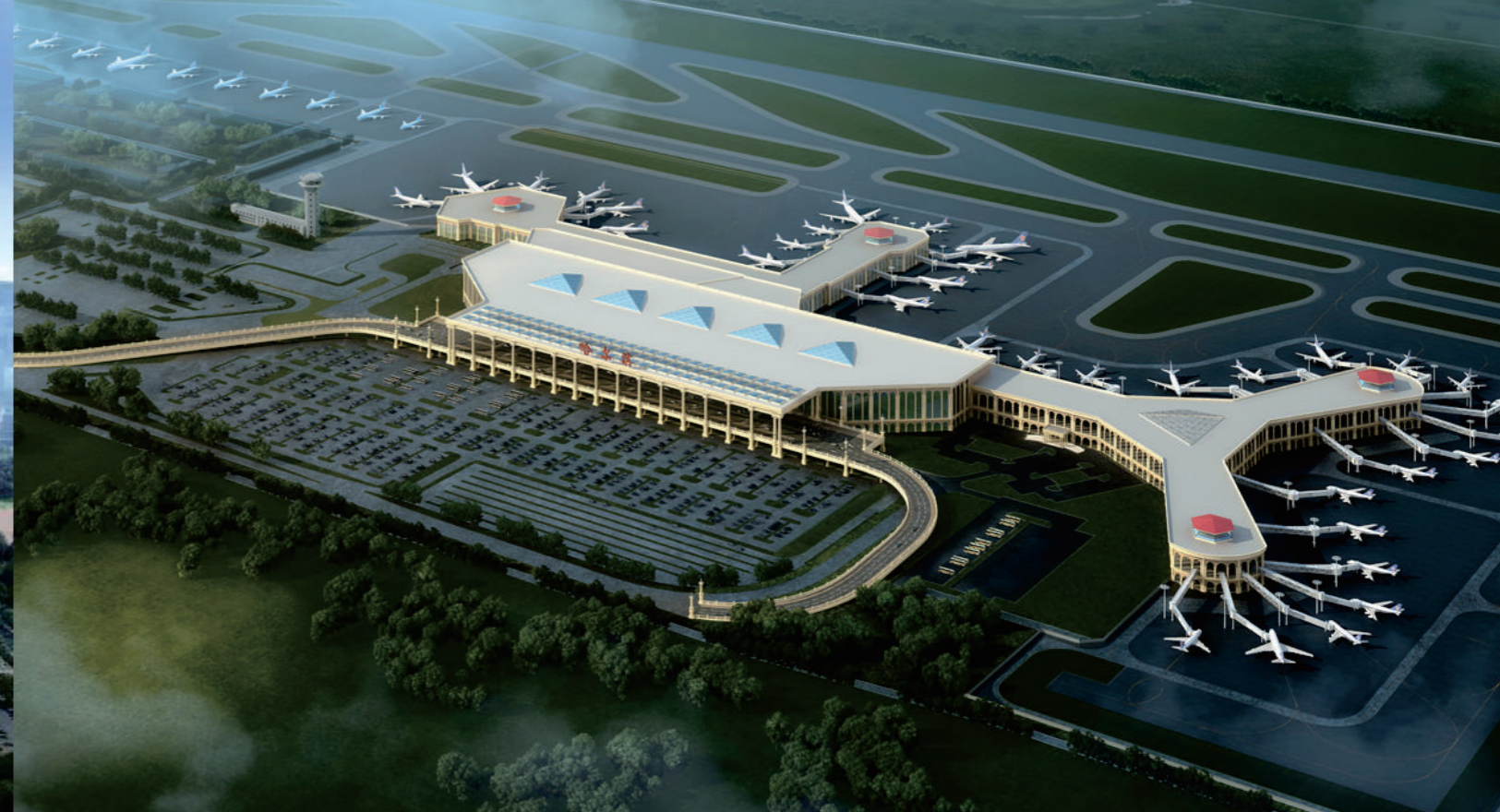
◎ 哈尔滨机场项目
